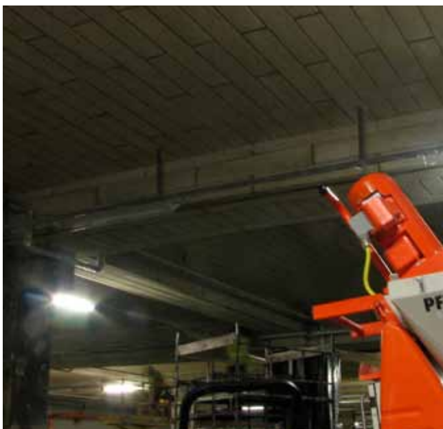
Agregat PFT Ritmo służący do natryskiwania tynku mineralnego Capatect 139 MG K15...
